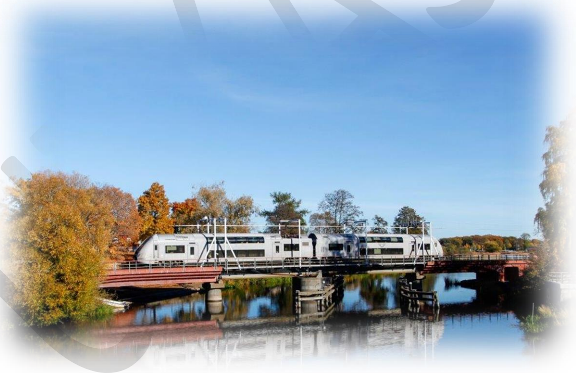
Bild: Tåg på järnvägsbro i Kungsör
