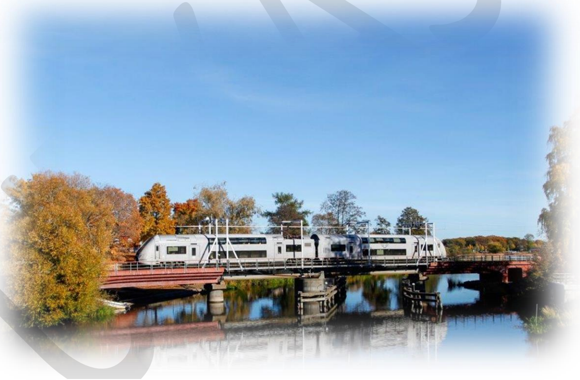
Bild: Tåg på järnvägsbro i Kungsör
