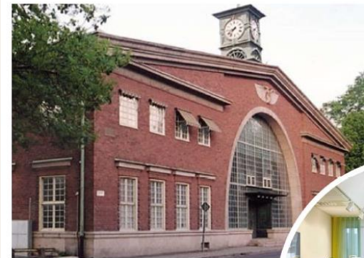
Södra station, Gävle
