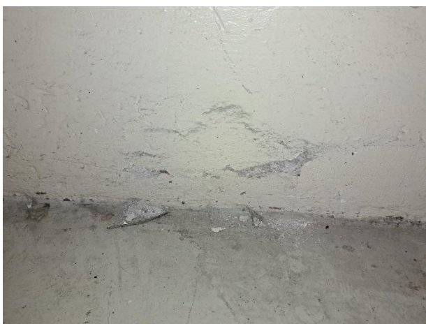
Foto 7 Mindre putssläpp nederkant källarvägg scenario 2
