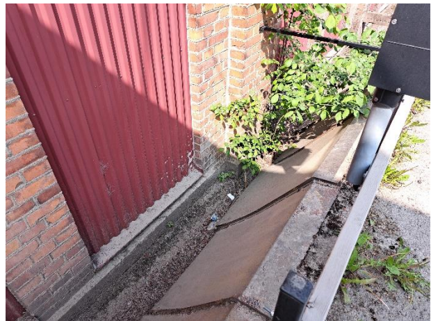
Foto 12 utvändig "dräneringskanal"
