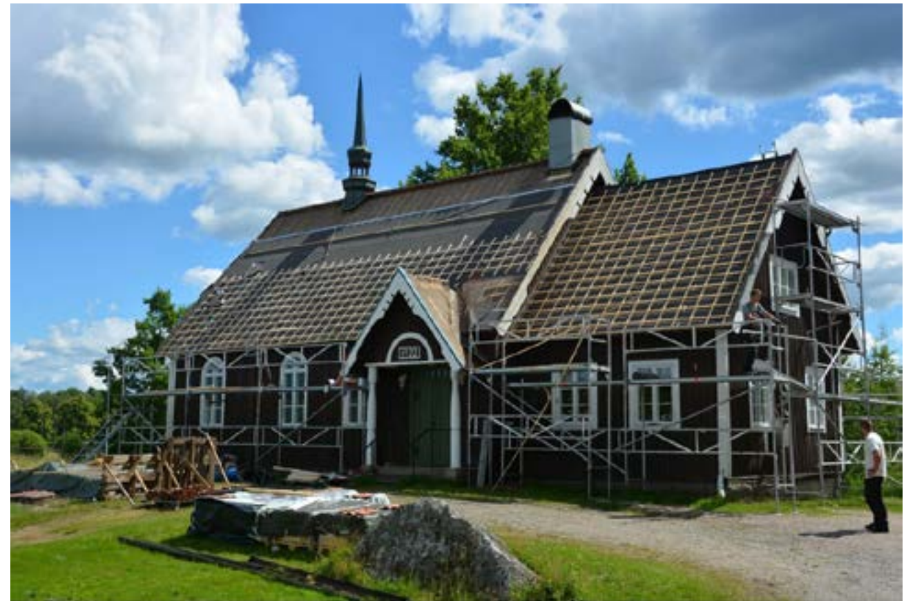
Takrenovering av Virsbo kapell, Surahammars kommun, sommaren 2022. Foto Västmanlands läns museum.
