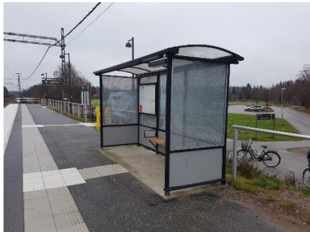
Exempel på klädd gallerhållplats vid Skyttorps station, Uppsala.
