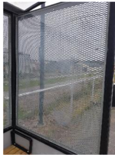
Exempel på klädd gallerhållplats vid Skyttorps station, Uppsala.
