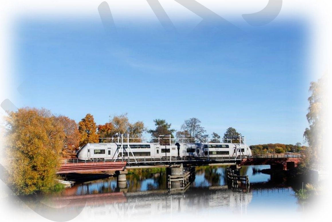
Bild: Tåg på järnvägsbro i Kungsör
