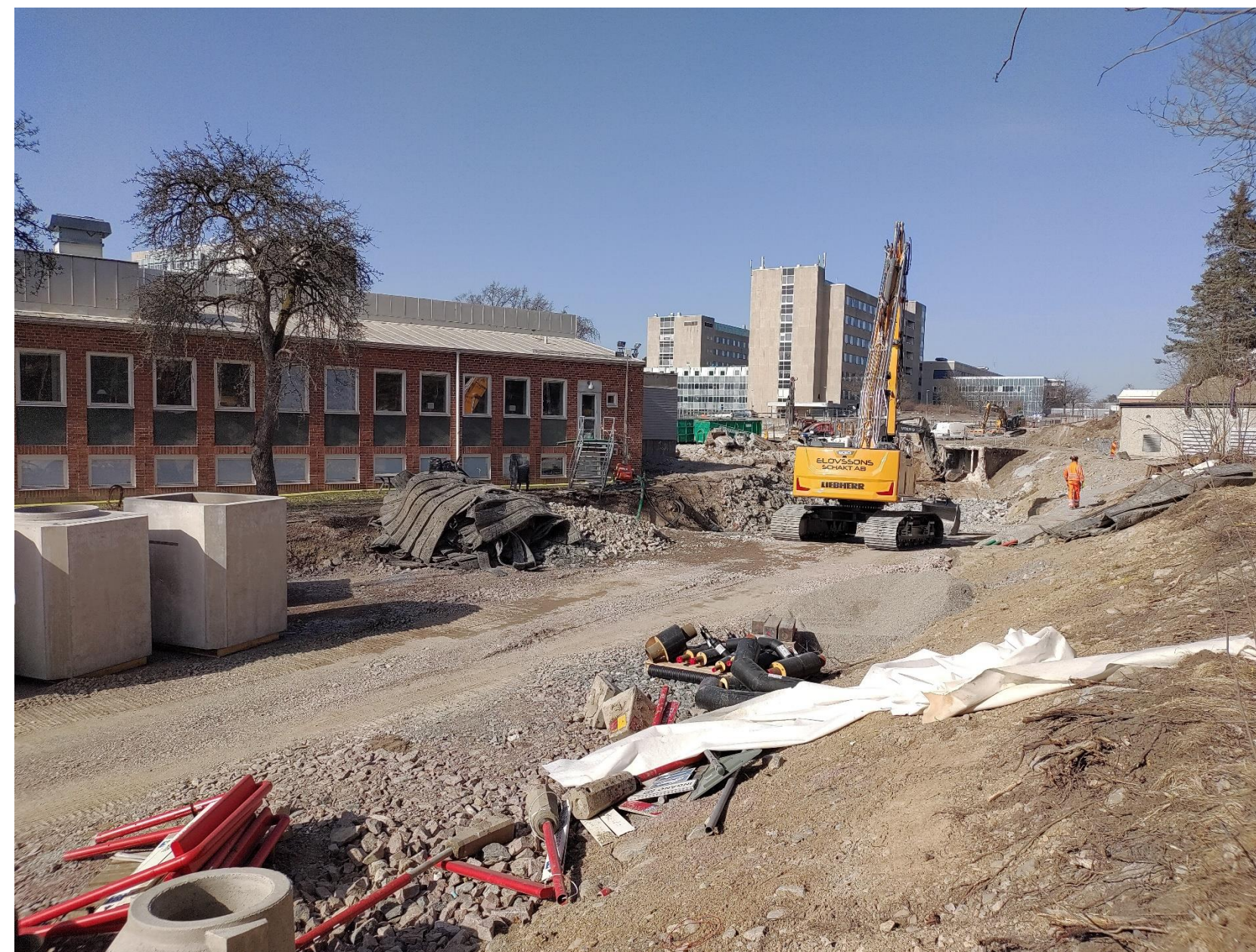
Gamla Lärcentrum är rivet och nu återstår markarbeten på platsen.
